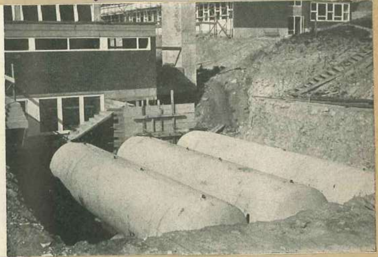
Einlagerung der Öltanks unter dem Spielfeld
