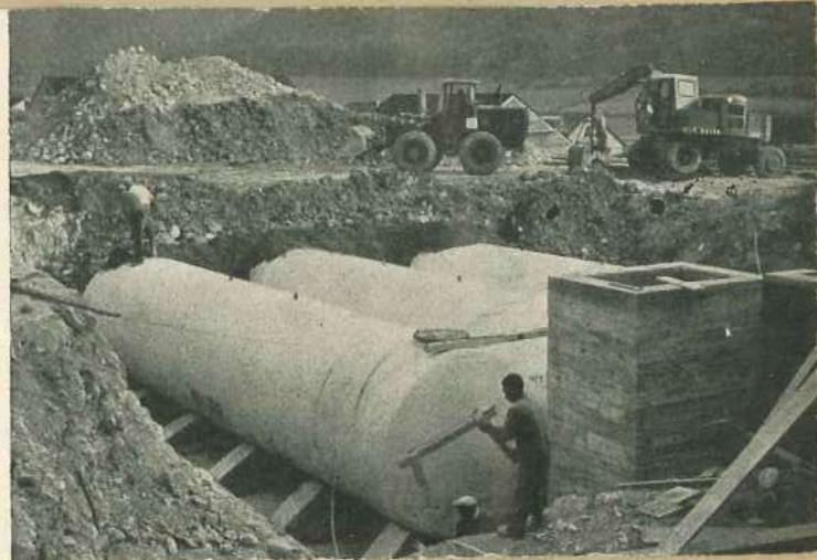
Abdeckung der Öltankgrube mit Sand und Erde Im Vordergrund ein Kontroll- schacht
