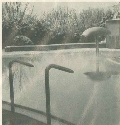
Das Außenbecken mit neuer Beckenfolie
